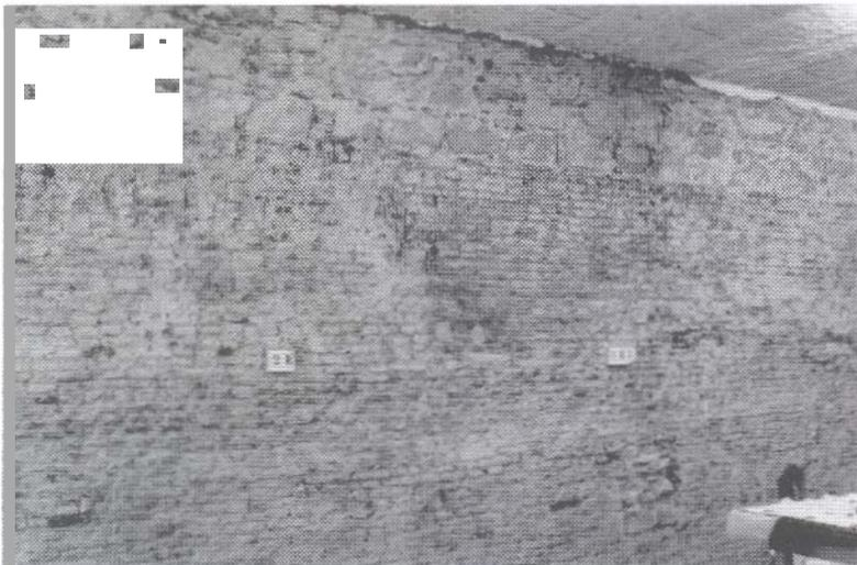
Figura 1. Trecho da mais antiga parede, construída em tijolos rejuntados com argamassa de cal. Observe-se a **ampliação** vertical em alvenaria de **pedra**.
