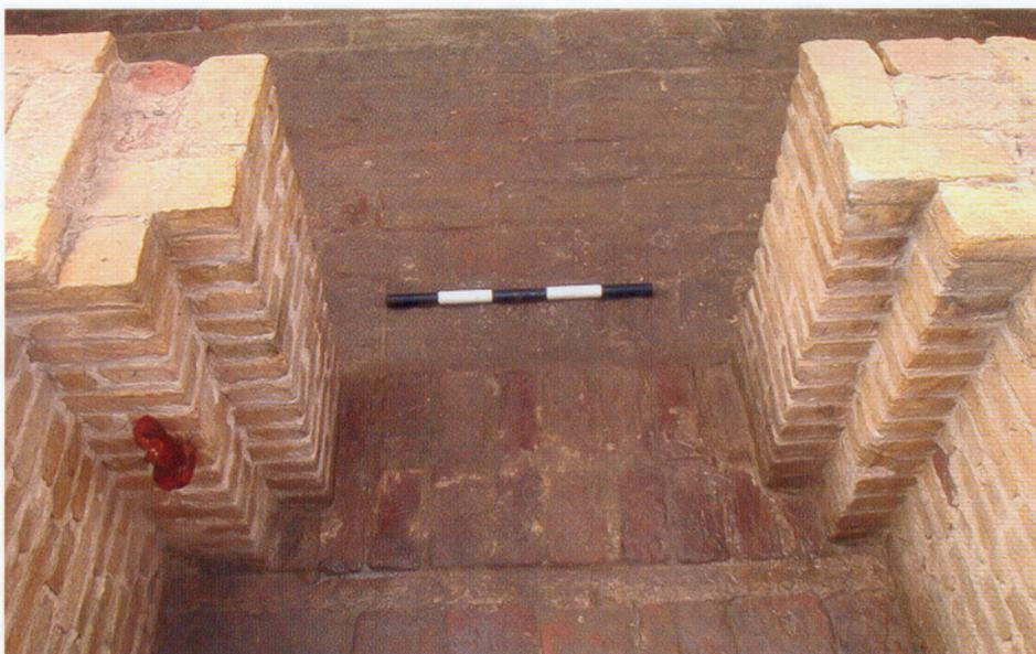
Ilustración 24. Detalle de la entrada del polvorín, construida con ladrillos amarillos holandeses. Se observa parte de la bisagra que soportaba la puerta interior, aún sujeta en la pared.
