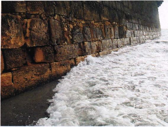
Por ocasião do recuo das ondas a água que penetrou nas frestas retorna, trazendo o sedimento do terreno.
