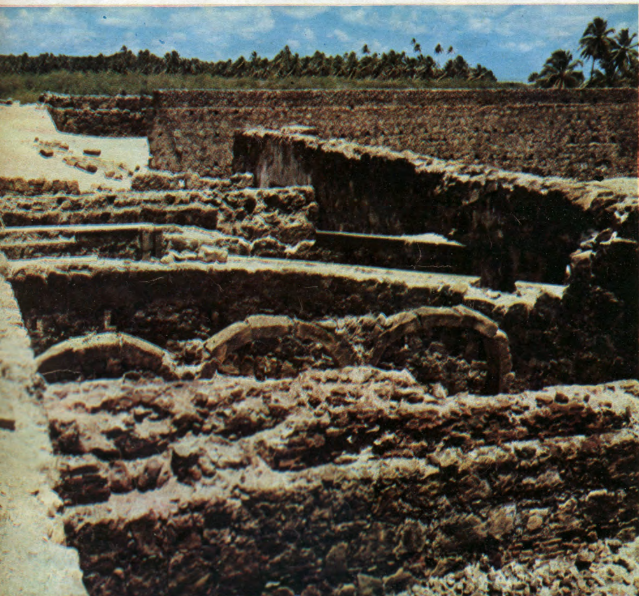
Compartimento por compartimento, Marcos descobriu 16 dependências no Forte de Orange, Itamaracá.
