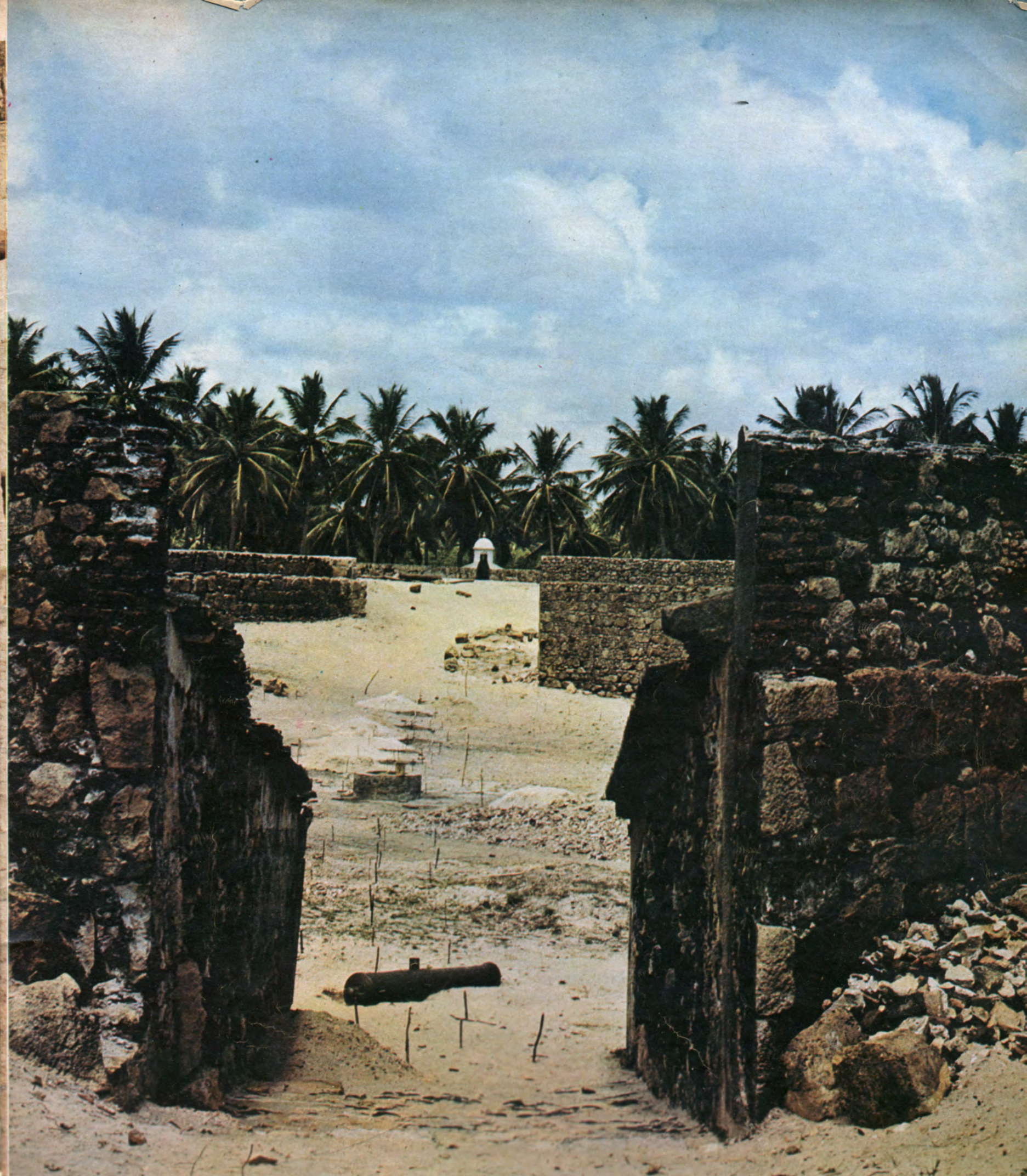
sua forma arquitetônica. Inicialmente construído em itaipa pelos holandeses, em 1631, êle foi, depois, reconstruído em pedra pelos portugueses.
